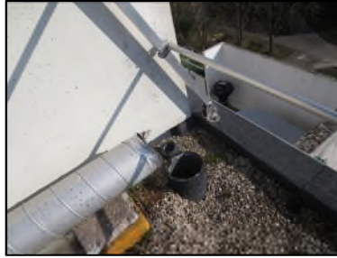
Photo N° 560 AMIANTE CIMENT TERRASSE Toiture Ventilation haute (Fibres-ciment)
